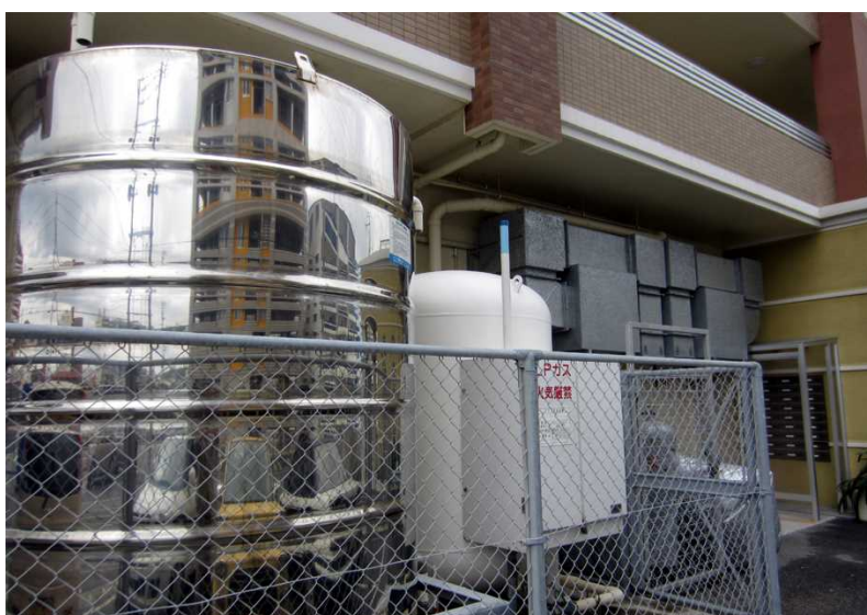
写真沖－ 15 LPガスタンク
